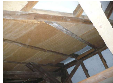
Zwischensparrendämmung
